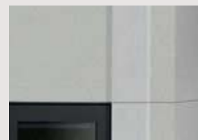
Structure béton à peindre
