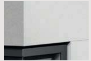
Structure béton à peindre
